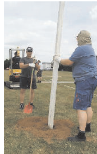
Hier werden 40 Masten für Licht und Lautsprecher gesetzt.
