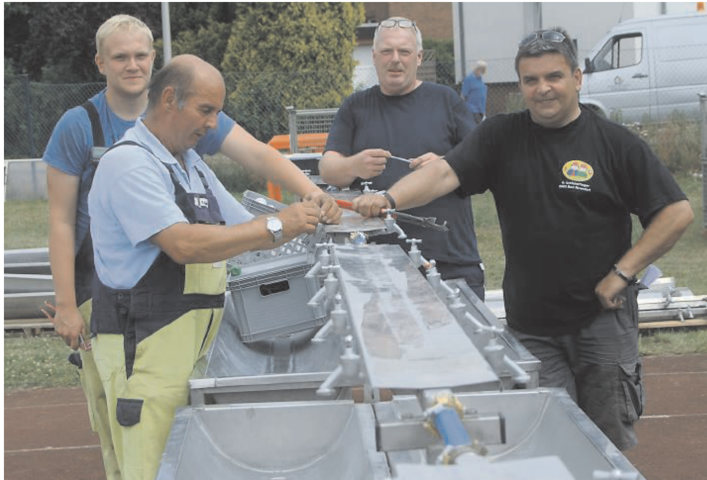
Mitarbeiter der Stadtwerke und des Bauhofes und der Feuerwehr montieren Wasserhähne und Waschanlage.
